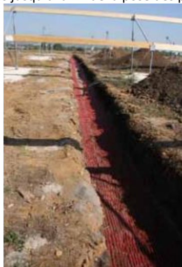
Ouverture d'une tranchée pour l'enfouissement des câbles
